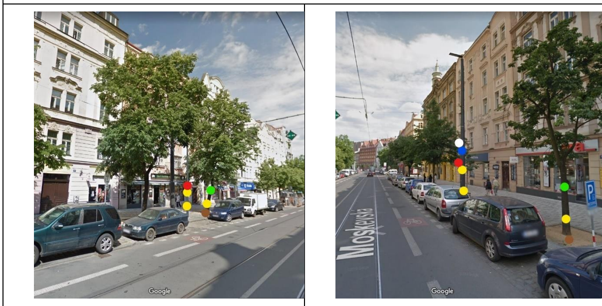
Situací umístění měřicích zařízení: Moskevská 20
